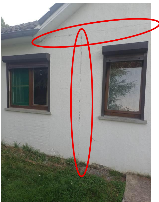
Photo 4 : fissure façade arrière
