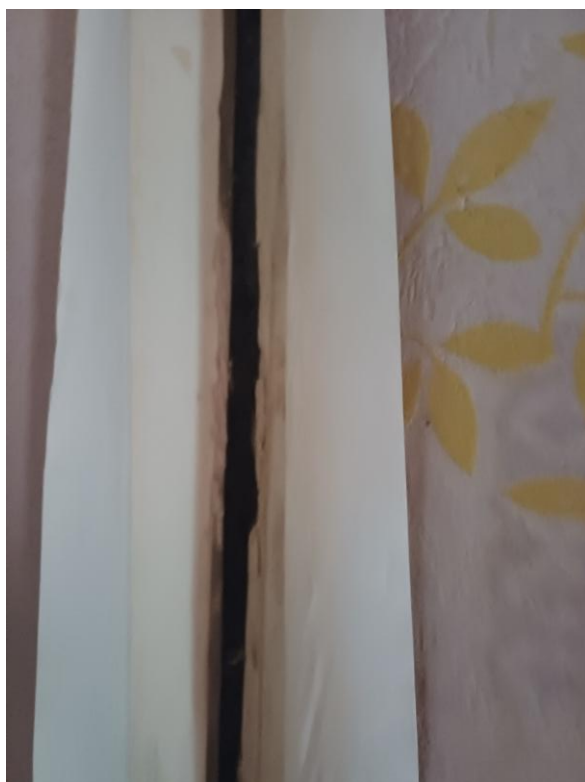
Photo 1 : fissure entre 2 murs perpendiculaires entre chambre 1 et façade arrière
