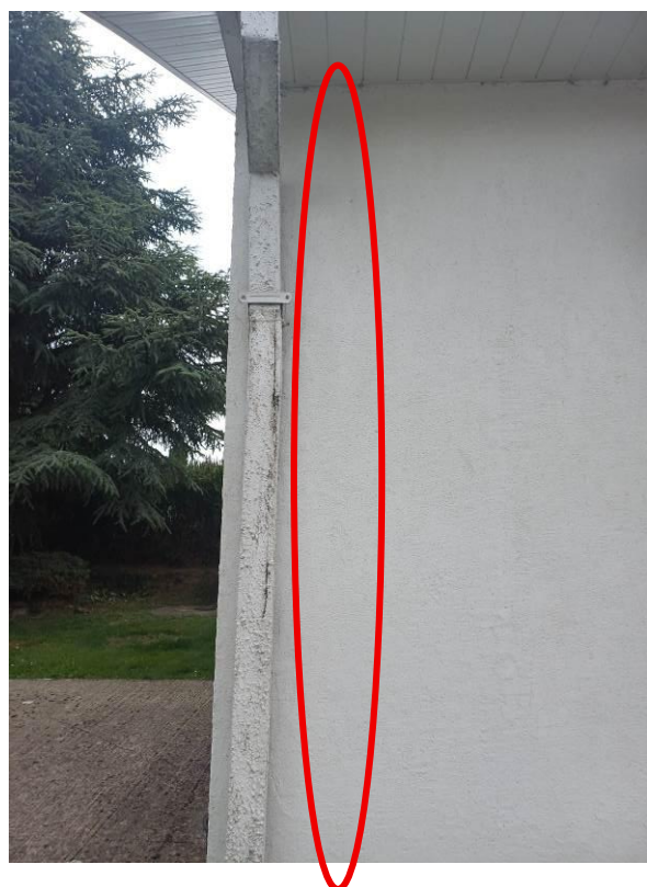
Photo 5 : fissure entre façade gauche et façade arrière
