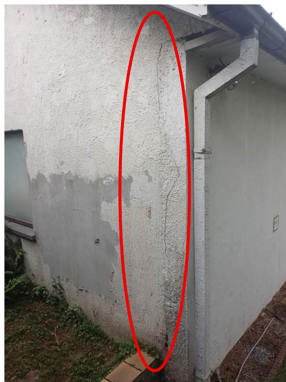
Photo 2 : fissure entre pignon droit et façade arrière
