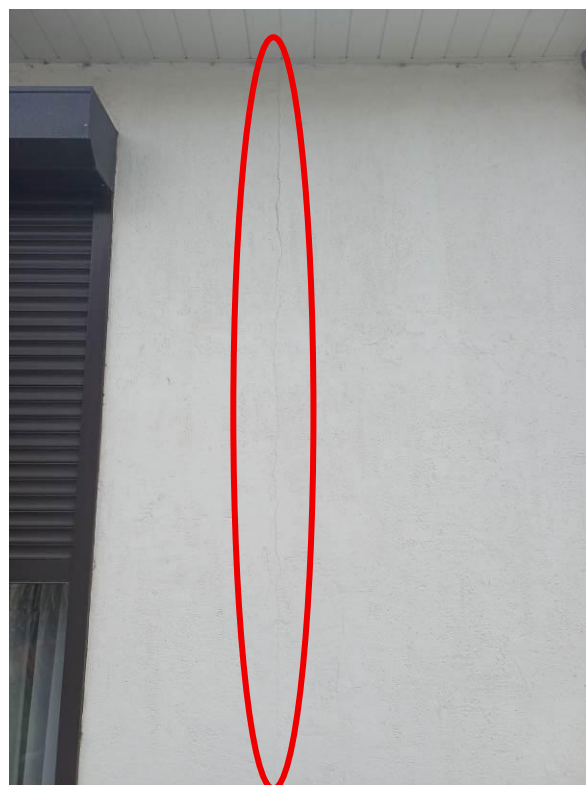
Photo 6 : fissure façade gauche
